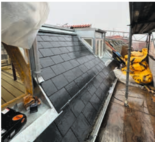
A/B Højdevej har også renoveret klimaskærmen.
