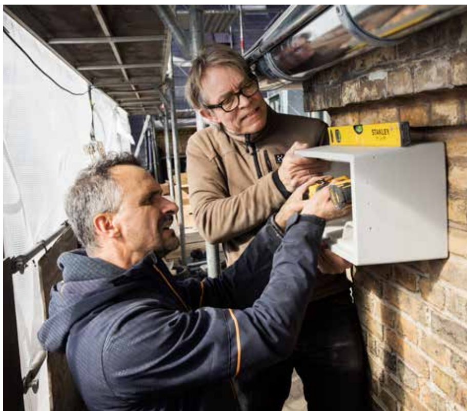
Det kræver kræfter at få de tunge redekasser i træbeton monteret på det gamle byggeri.
